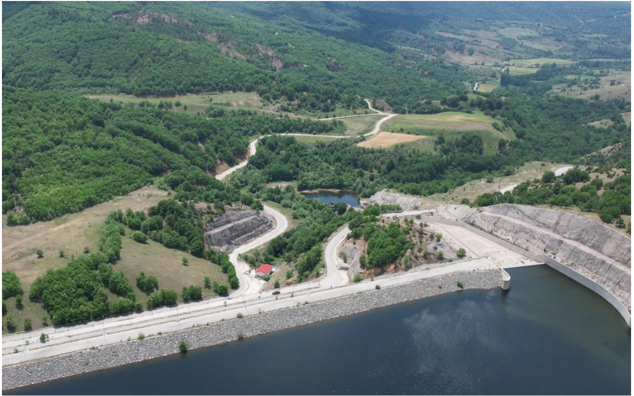
Φωτογραφία 7 Ταμιευτήρας και φράγμα Παπαδιάς. Στα δεξιά, διακρίνεται ο υπερχειλιστής (Μάιος 2021, προσωπικό αρχείο Άρη Ψιλοβίκου)
