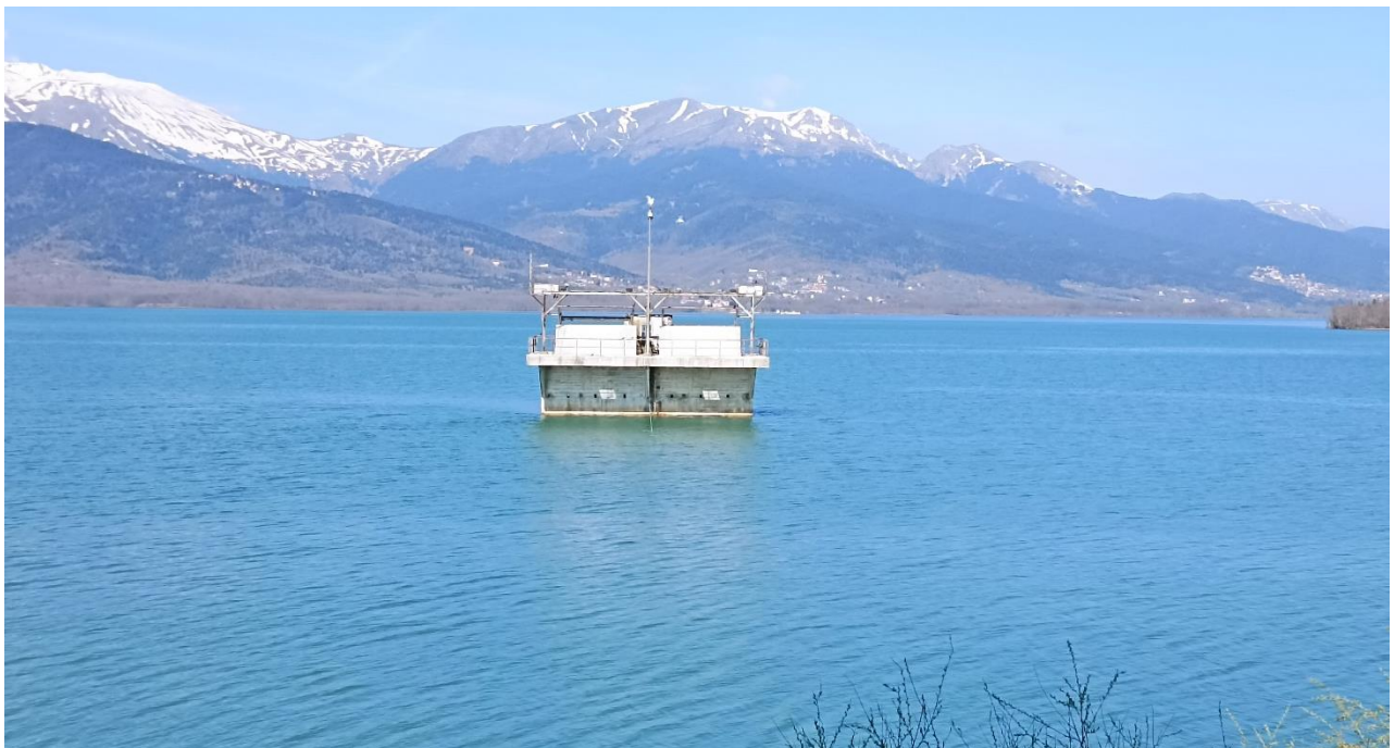
Φωτογραφία 6β Η εγκατάσταση της υδροληψίας της ΔΕΗ στο ΒΑ τμήμα της λίμνης Πλαστήρα (Απρίλιος 2022, προσωπικό αρχείο Άρη Ψιλοβίκου)
